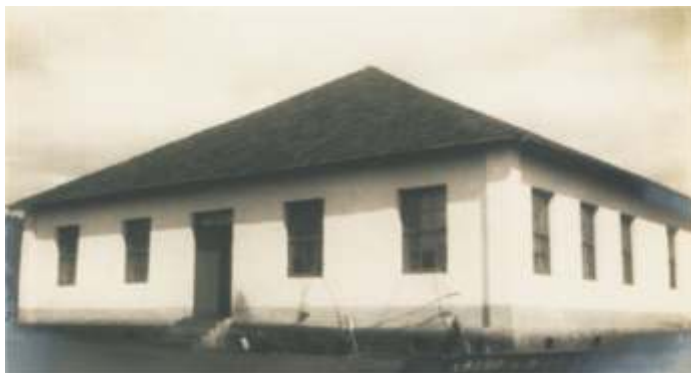
Grupo Escolar de Santa Rosa, construído e cedido gratuitamente pela Sucrérie.
