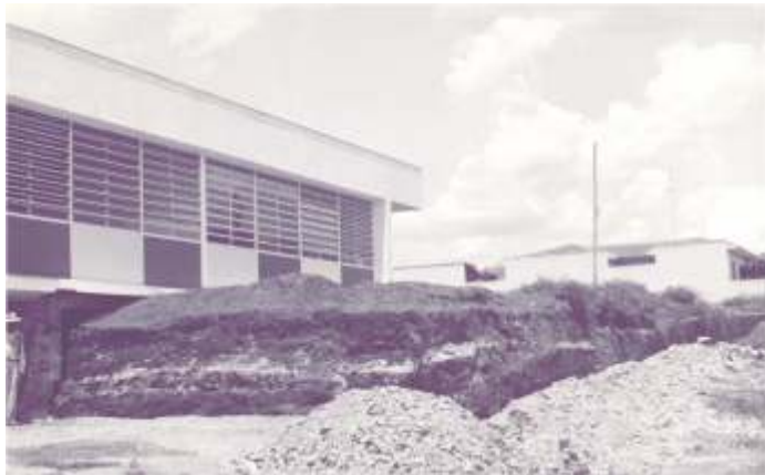
E.E. 'Mons. Jeronymo Gallo' em obras.
