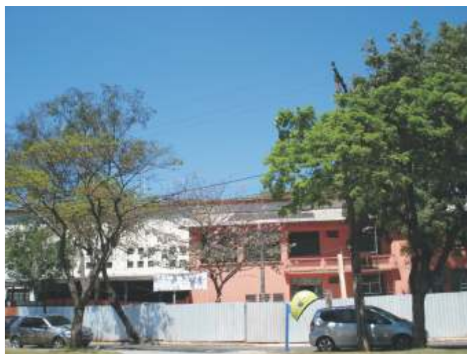
E.E. 'João Batista Nogueira' em obras de manutenção.
