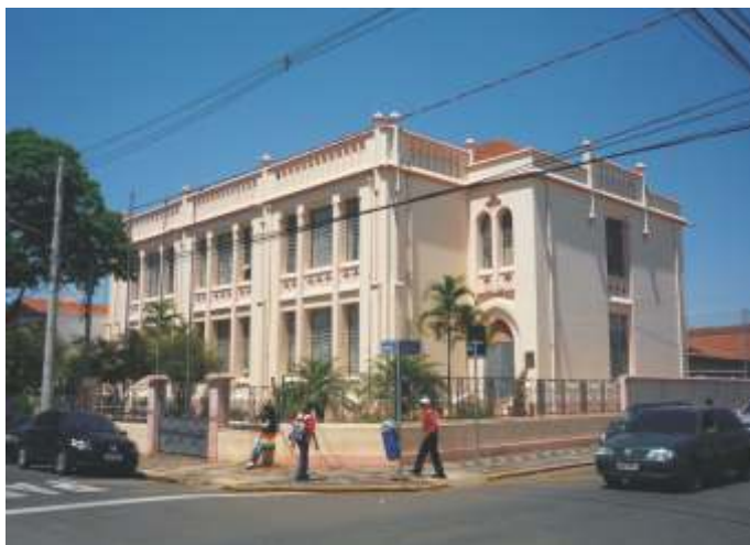
Escola Estadual 'Barão do Rio Branco' após obras de recuperação.
