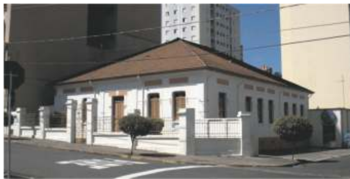
Vista atual do edifício.
