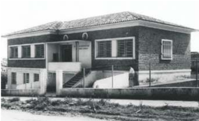
E.M.E.I. 'Joaninha Morganti' recém-construída.
