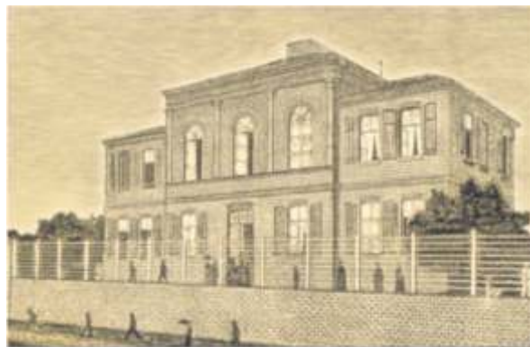
Edifício Principal recém construído.
